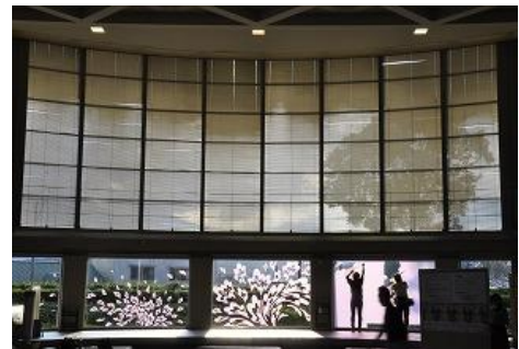
図 27 小林市文化会館エントランスにて施工開始
